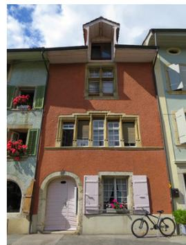
Diese Fassade zeichnet sich durch die Grösse der Fenster aus. Das eine Fenster im ersten Stock besteht aus fünf Teilen in pyramidalen Anordnung, das andere in der zweiten Etage besitzt ein Steinfensterkreuz. Im Erdgeschoss eine Niederbogentür aus dem Jahr 1555 und daneben ein Fenster aus neuerer Zeit.
