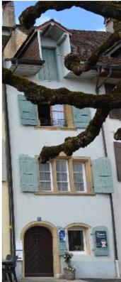
Das Erdgeschoss ist von einer Korbogentür und einer heute teilweise zugemauerten Ladengeschäfts-Arkade durchbrochen; im ersten Stock bemerkt man ein dreiteiliges Fenster mit Steinfensterkreuzen und erhöhter zentraler Front (von 1556). Im zweiten Stock sieht man ein einfacheres Fenster dessen Pfosten entfernt wurde.
